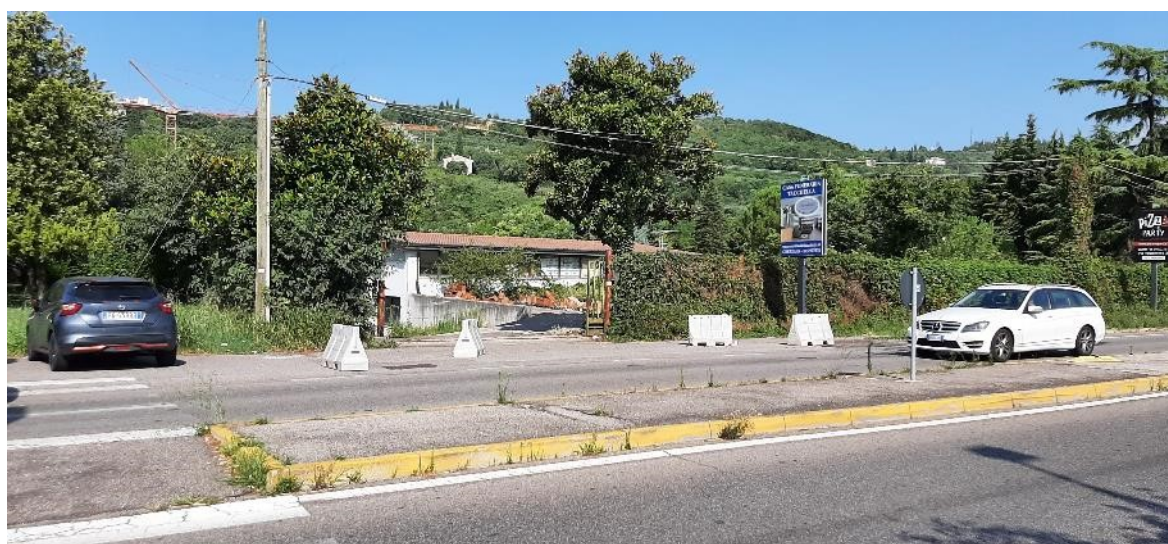
Figura 22 – Attuale attraversamento stradale di collegamento con il supermercato Esselunga vista da Est.
